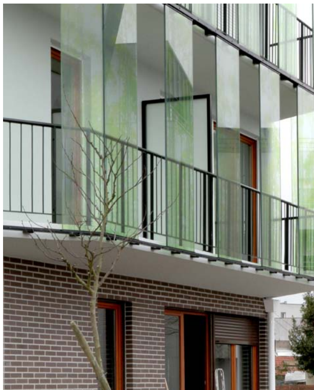
Le balcon filant et sa double peau en verre sérigraphié
