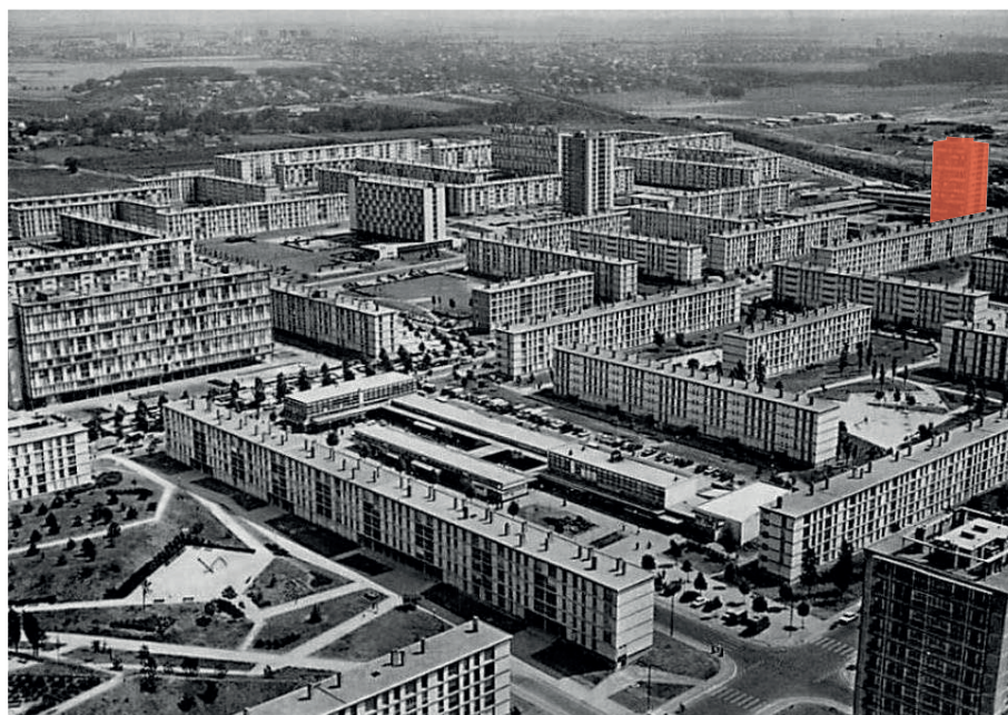
Vue aérienne du grand ensemble des Lochères La tour Ravel se situe à droite de l'image (surlignage orange)
