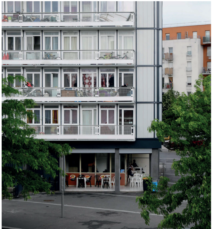
Détail de la façade de la tour Ravel Gare après travaux, 2019. © Coline Bublex
