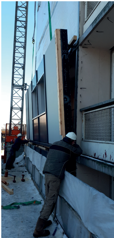
Photographies de la pose des façades préfabriquées © Equateur
