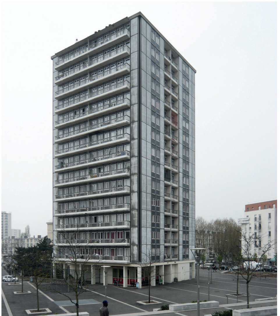
La tour Ravel avant la réhabilitation
